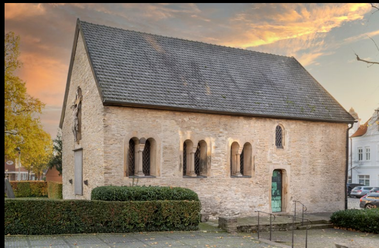
Die Petrikapelle ist eines der ältesten Bauwerke der Gesamtanlage des Stiftes Freckenhorst. Hier ist die Stiftskammer untergebracht.
